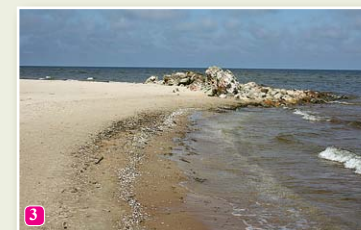
Развалины старого Колкасагского маяка
